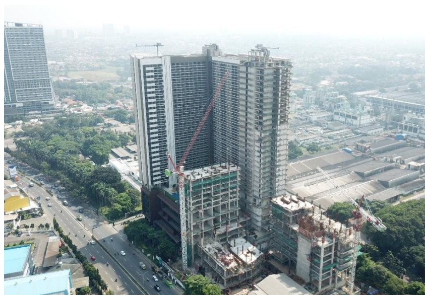
Foto: Progres konstruksi The Scott Collins Boulevard, Tangerang
