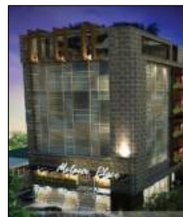
Pembangunan Proyek Melrose Place Dormitory
