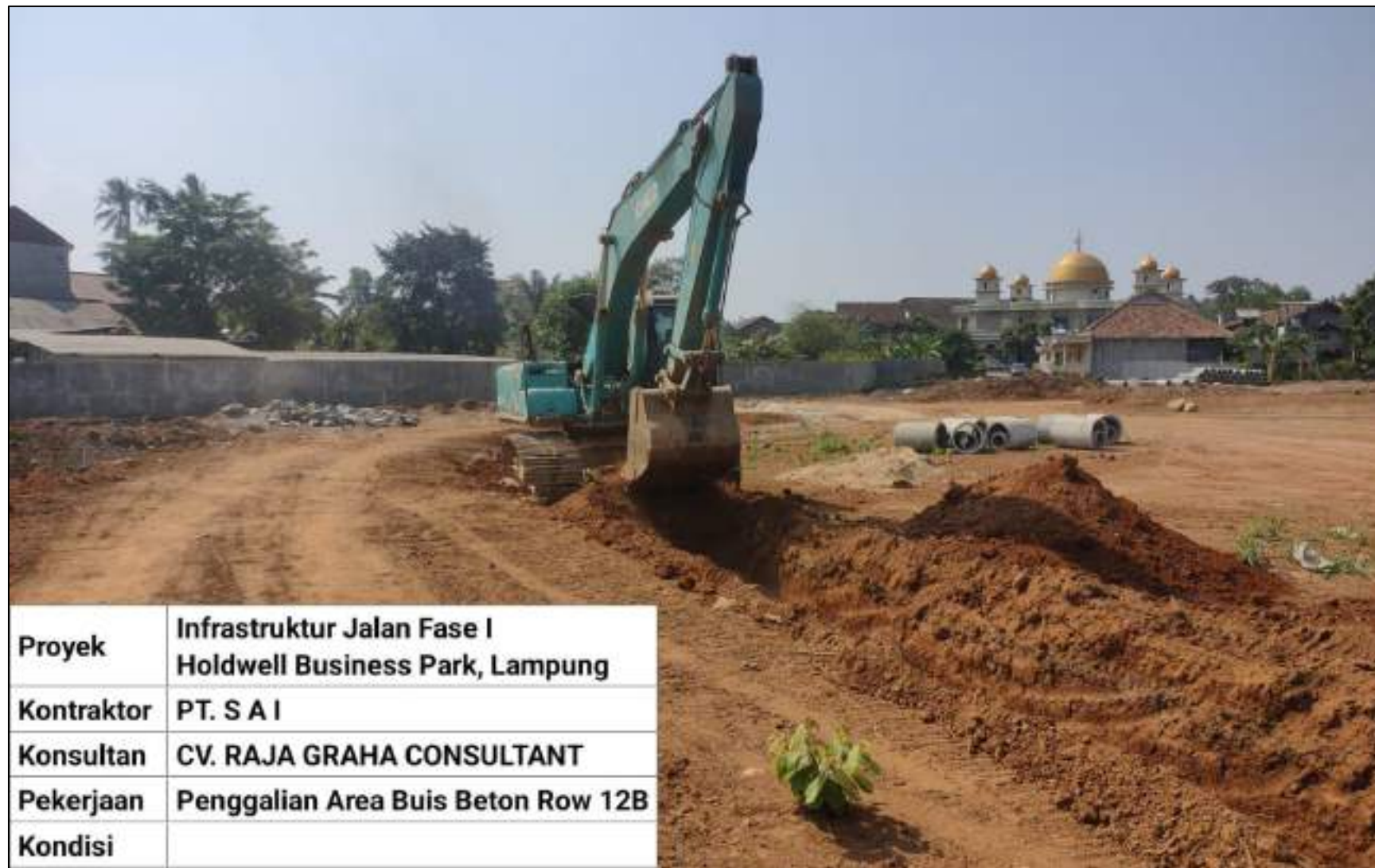
Pembangunan Infrastruktur Jalan
