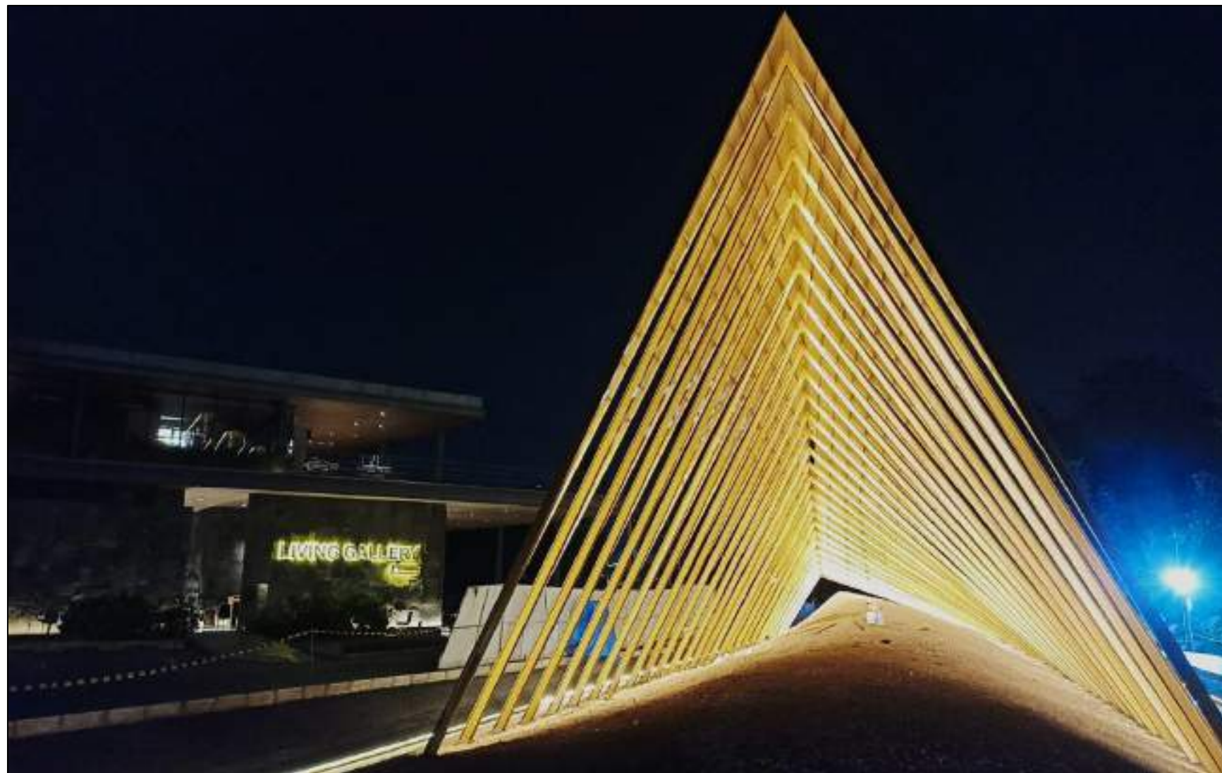
Pembangunan Gerbang Utama
