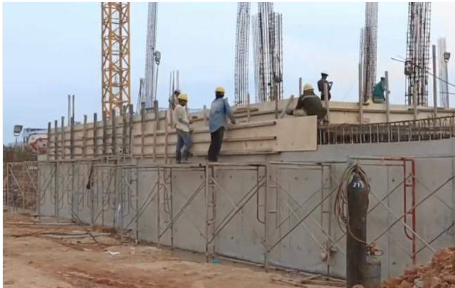
Progres Pembangunan Paul & Prive
