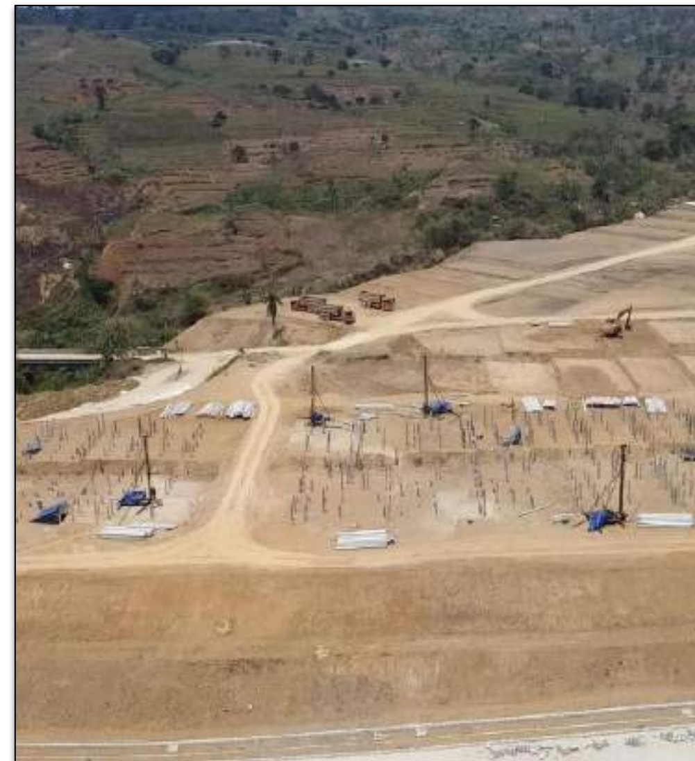
Pembangunan Tiang Pancang Cluster I The Leroy
