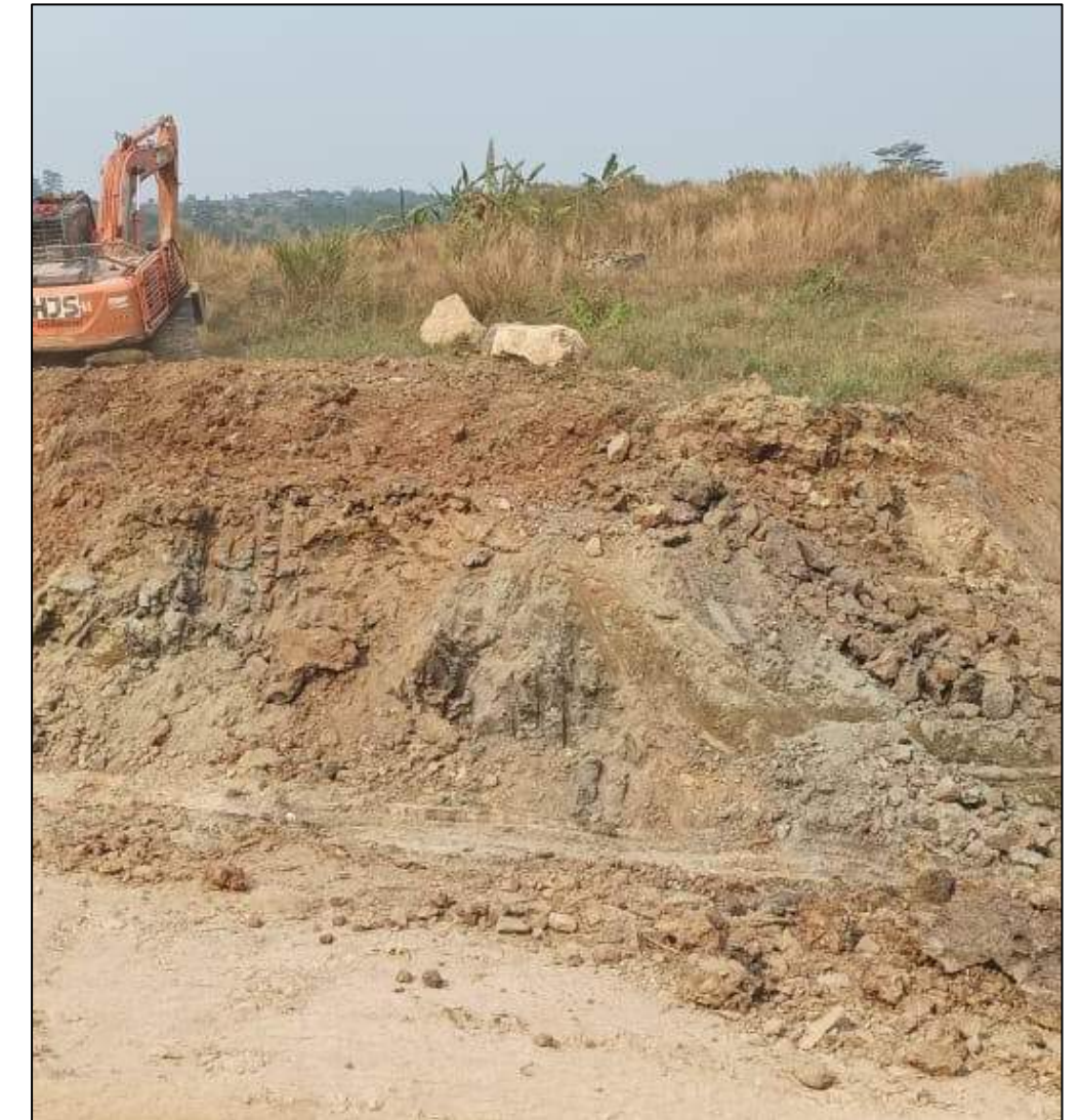
Pembangunan Akses Jalan Cluster I The Leroy
