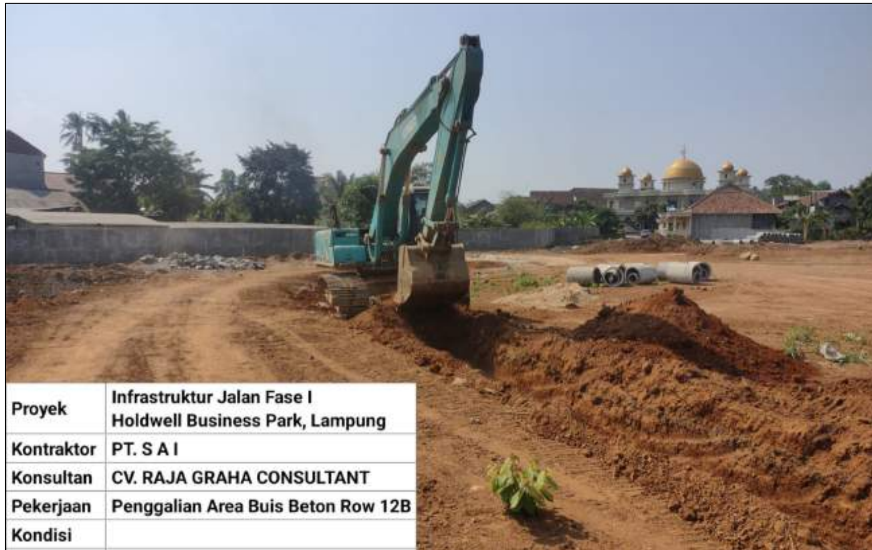
Pembangunan Infrastruktur Jalan
