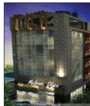
Pembangunan Proyek Melrose Place Dormitory
