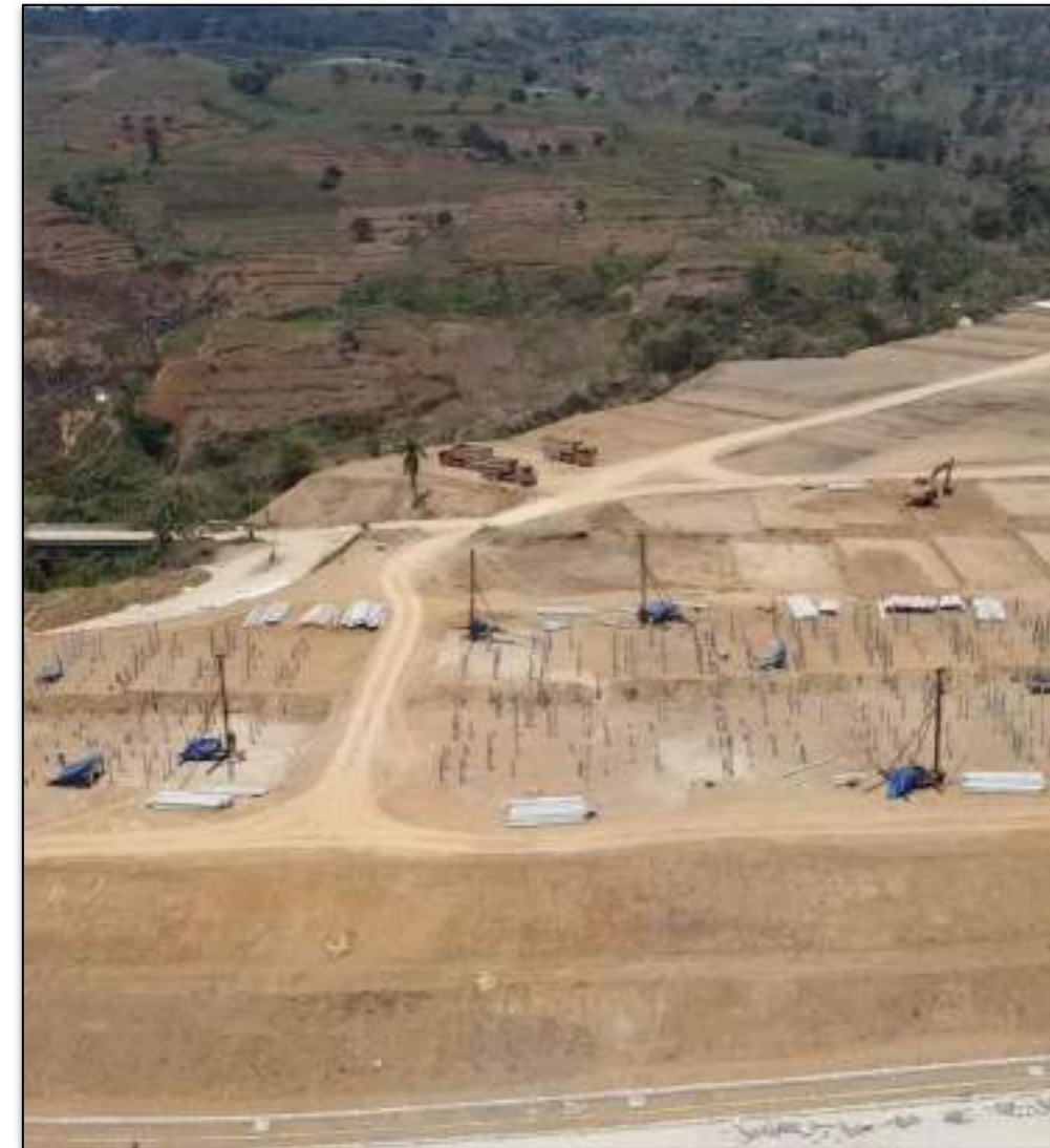
Pembangunan Tiang Pancang Cluster I The Leroy
