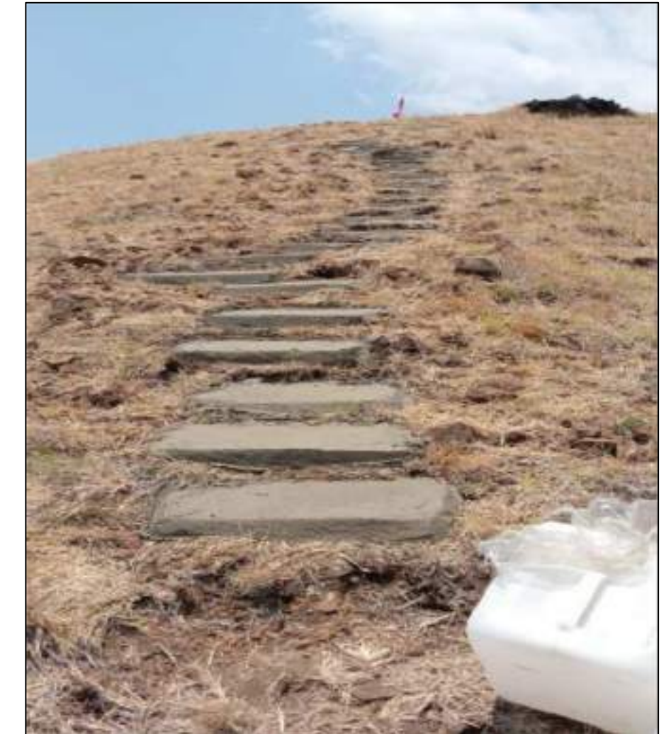
Pembangunan Path Walk
