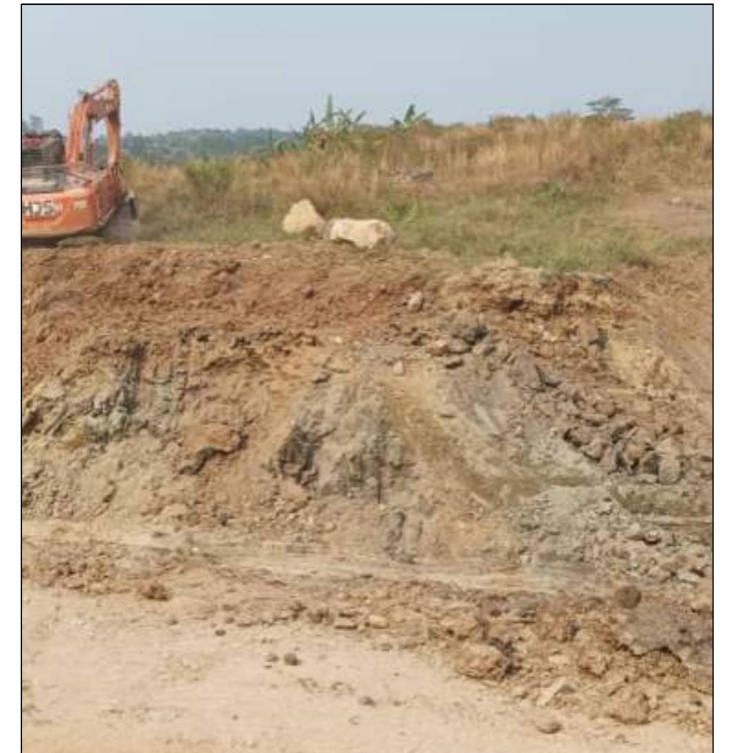
Pembangunan Akses Jalan Cluster I The Leroy
