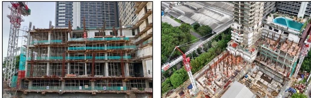
Pengerjaan pengecoran lantai
